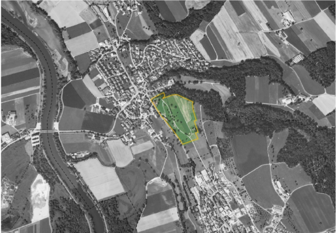
Abb.: Luftbild Areal „Mühlegg“
