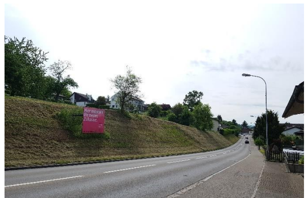
f) Blick auf Böschung von Zugerstrasse
